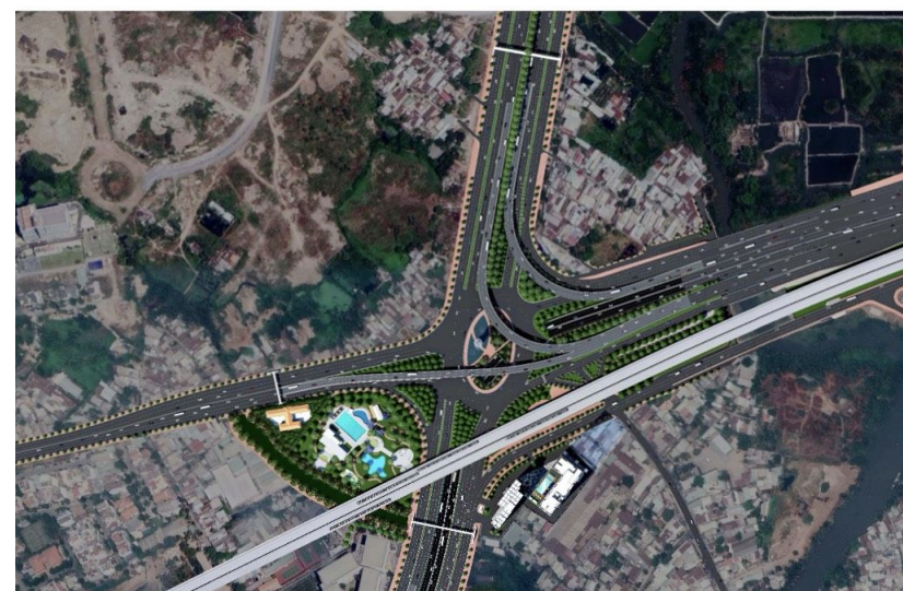
Nút giao An Phú (Dự kiến hoàn thành Q2/2025)
